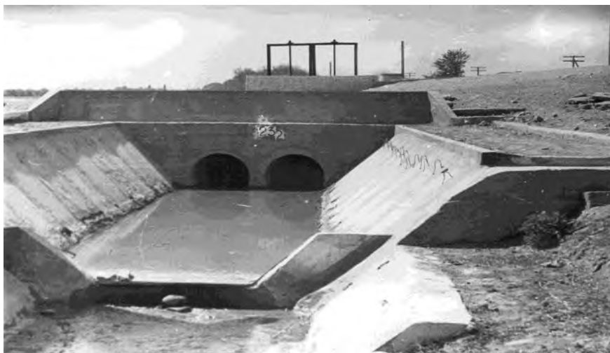
Рис. 4 Оросительная система ЗБЧК. Гидропост на Р-23-2: Водослив находится вблизи к трубчатому водовыпуску и имеет примитивное наносопромывное отверстие
