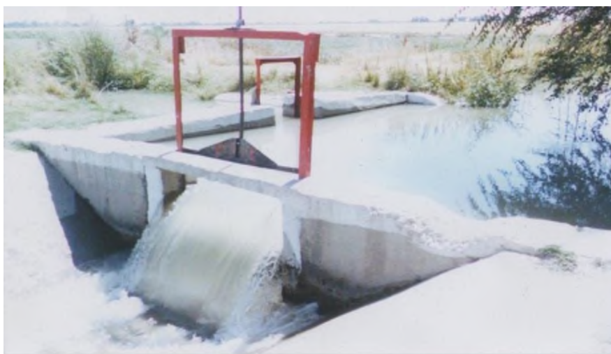
Рис. 9 Затвор-водомер на Р-7-13 прямой системы Ат-Башинского магистрального канала.
