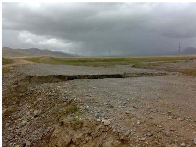
Рис. 6. Трасса, разрушенная в результате схода селя на км 460.
