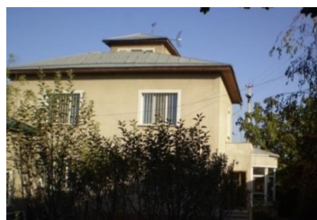
Рис. 2. Энергоэффективный дом с солнечным нагреванием и ночным охлаждением вертикально-сквозным проветриванием и длинноволновым облучением небосвода
