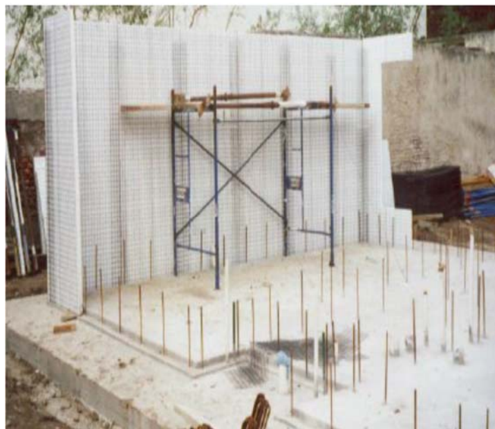
9-сурөт. Дубалды монтаждоонун технологиясы
