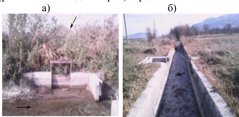
Рис.2 Водомеры типа «Фиксированное русло» на отводе из каналов СХ-3 системы ЗБЧК (а) и Орто-Алыш с.к. Туш (б). (стрелкой на фото а – показано место нахождение гидропоста, который зарос камышом и заилен наносами; на фото б – гидропост заилен наносами толщиной более 20см.
