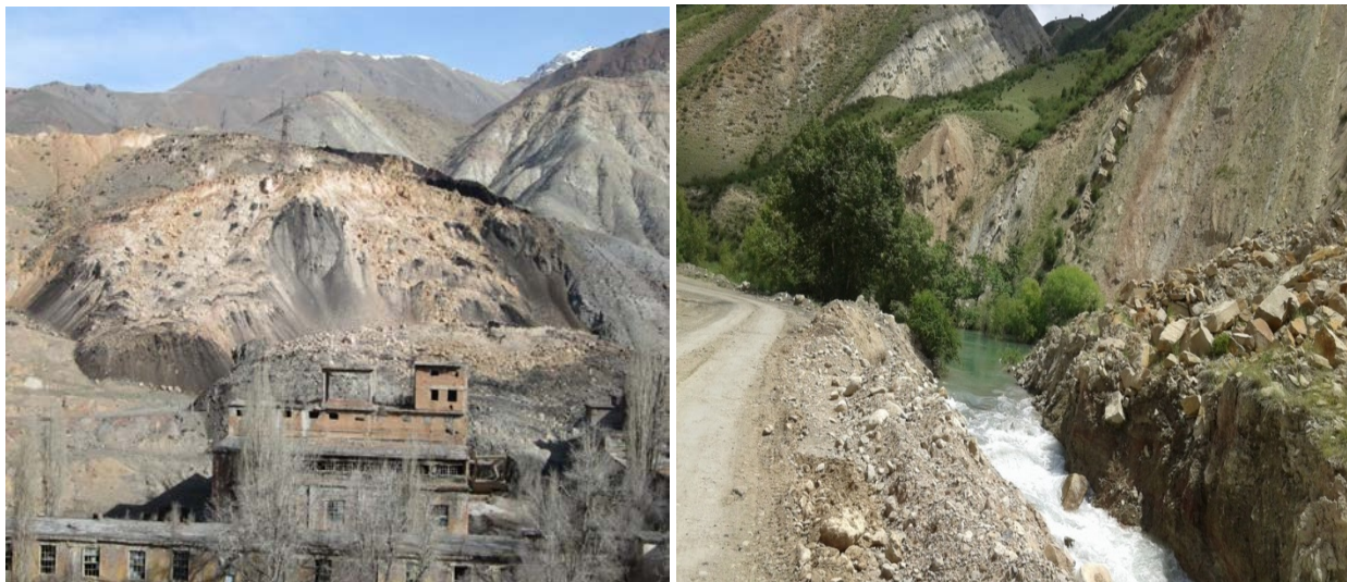
а) оползень вблизи бывшего завода в 2013г (б) оползень на левом берегу реки в июне 2015
