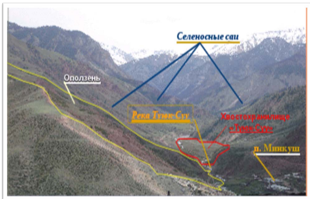
Рисунок 1.3.2 - Риск оползня в районе хвостохранилища “Туюк-Суу”
