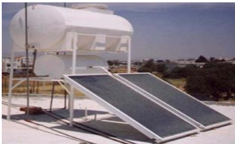
Рисунок 1.1 - Одноконтурный солнечный водонагреватель с термосифоном
