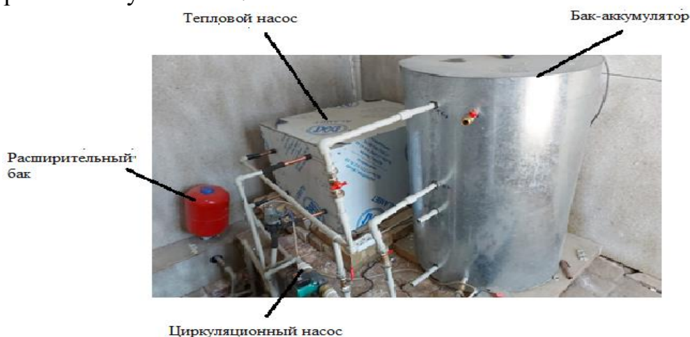
Рисунок 3.7 - Промышленный образец и общий вид двухконтурной гелиоустановки
