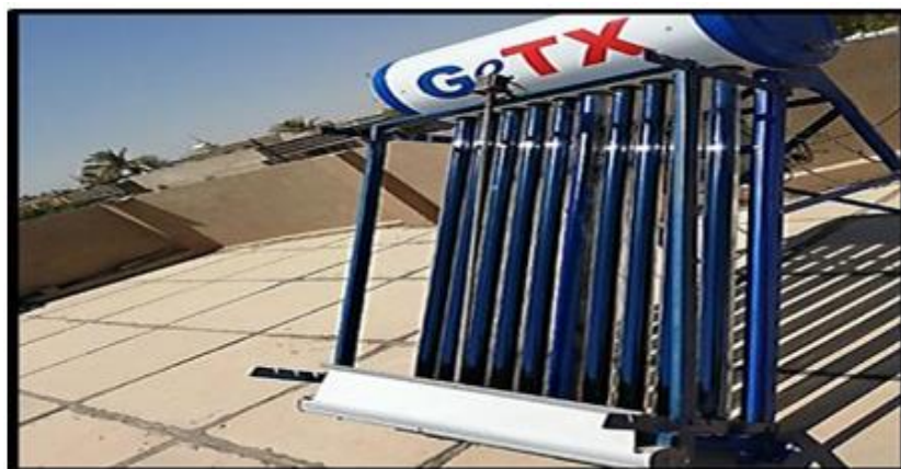
Рисунок 1.22 - Трубчатый солнечный коллектор
