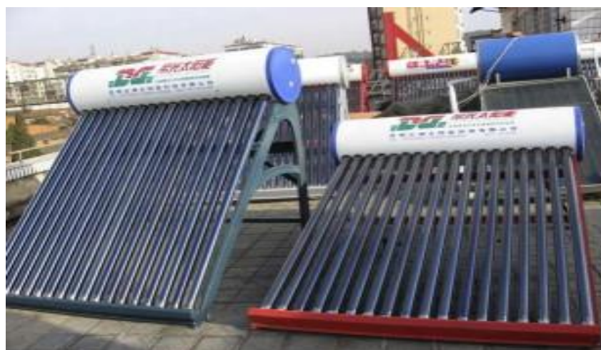
Рисунок 1.2 - Одноконтурные солнечные водонагреватели
