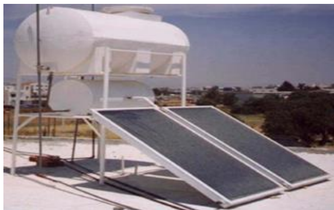
Рисунок 1.1 - Одноконтурный солнечный водонагреватель с термосифоном
