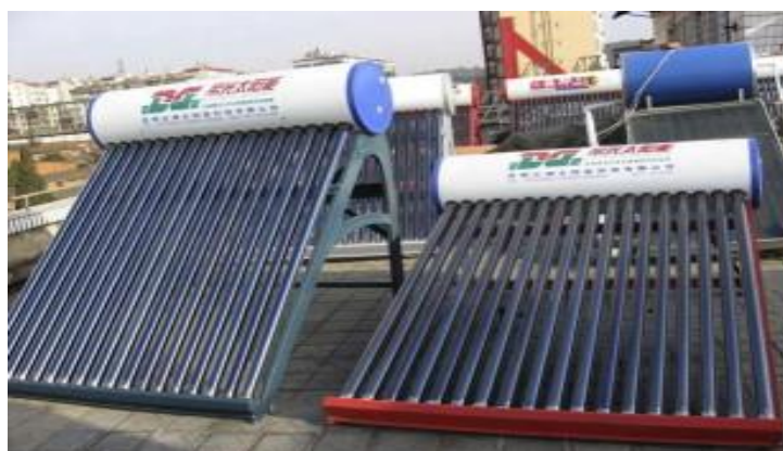
Рисунок 1.2 - Одноконтурные солнечные водонагреватели
