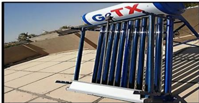
Рисунок 1.22 - Трубчатый солнечный коллектор
