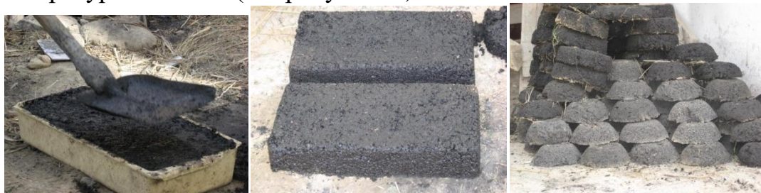
Рисунок 8 – Послойная набивка смеси в съемную форму – опалубку, естественная сушка брикетов, складирование.
