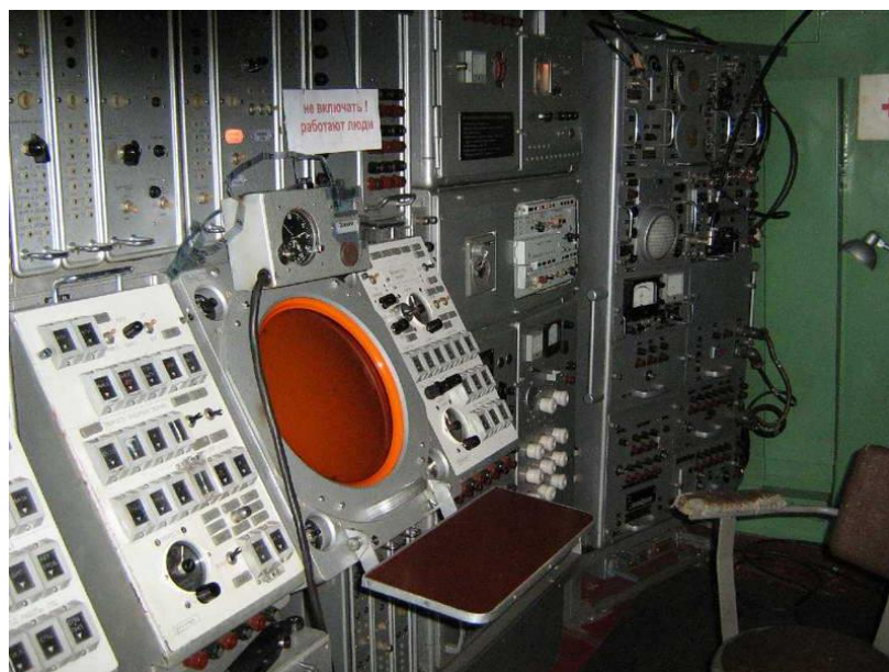
Рисунок 2.8 – Внешний вид стоек с аппаратурой станции
