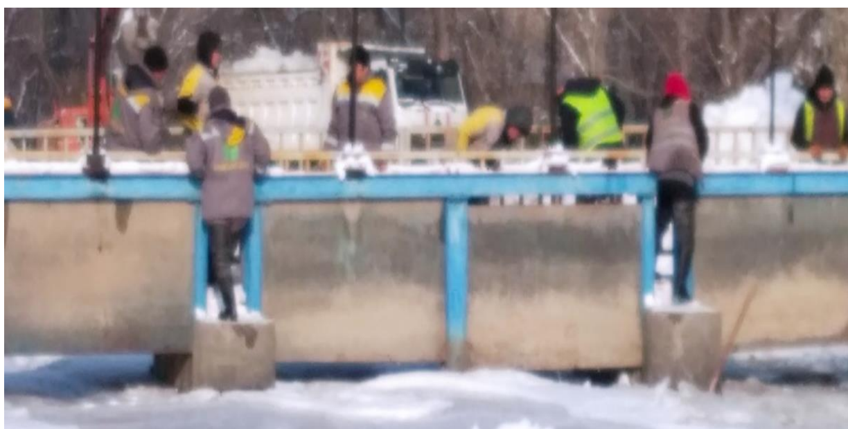
Рисунок 2.1.1 – Вид на заторы в русле реки Ала-Арча, сформированные из зажорных накоплений за сооружением, в холодный ночь с 12 на 13 январь 2023 г.
