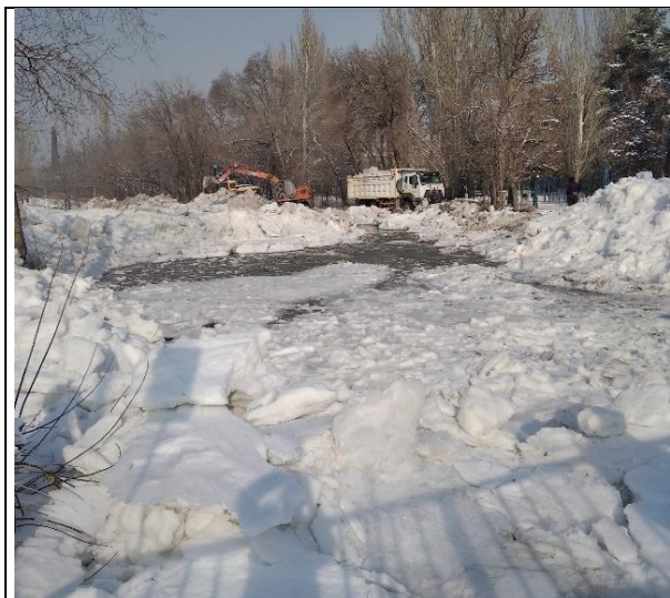
Рисунок 2.1.3 - Ликвидация «тела» и «головы» зажорного затора за сооружением. снимка 13 января 2023 года
