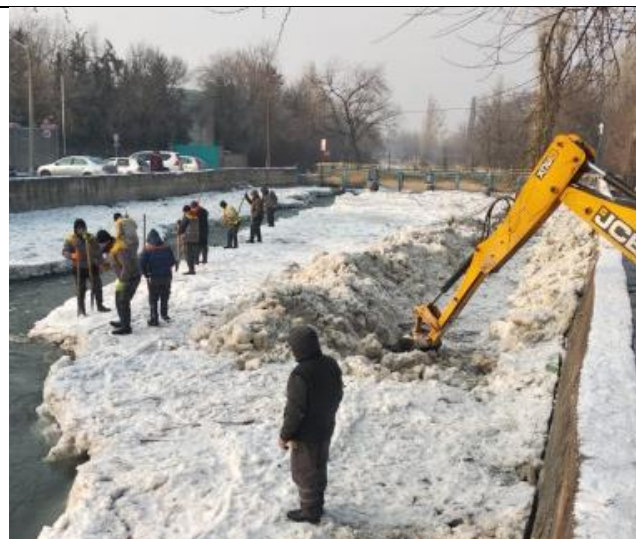
Рисунок 2.1.4 - Вид на отвод воды из-под зажорного покрова на участке до сооружения. снимка 13 января 2023 года
