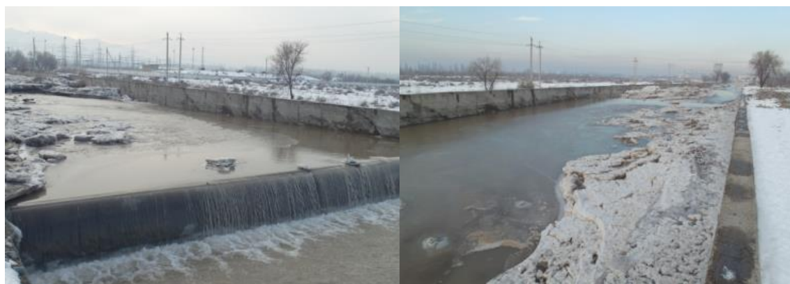
Рисунок 1.1.8 - Пороги гасят скорость потока и способствуют накоплению воды
