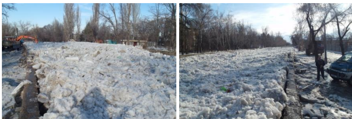
Рисунок 1.1.5 - Скопление шуги в русле реки Ала-Арча перед шлюзами водораспределителя по ул. Скрябина
