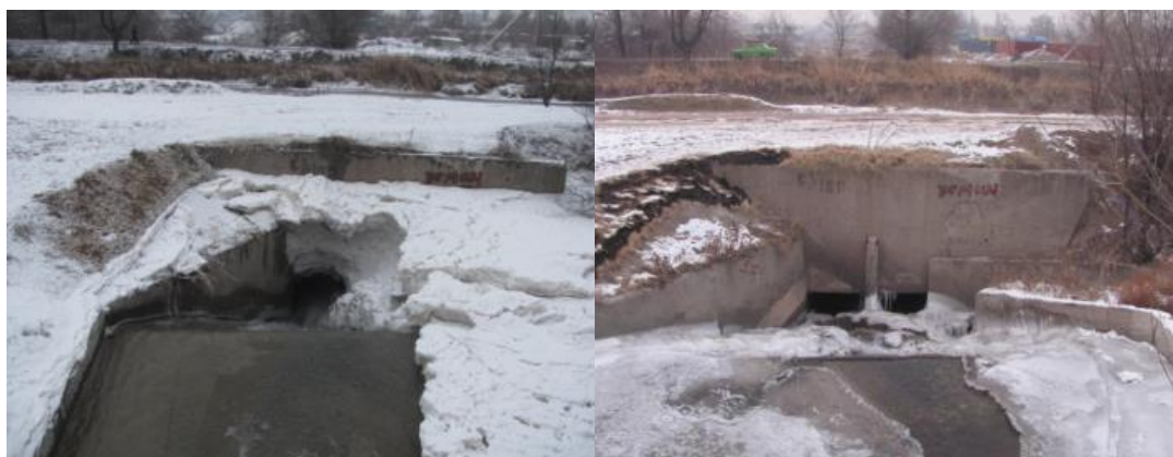
Рисунок 1.1.9 -Участок затопления выше водосброса под каналом БЧК
