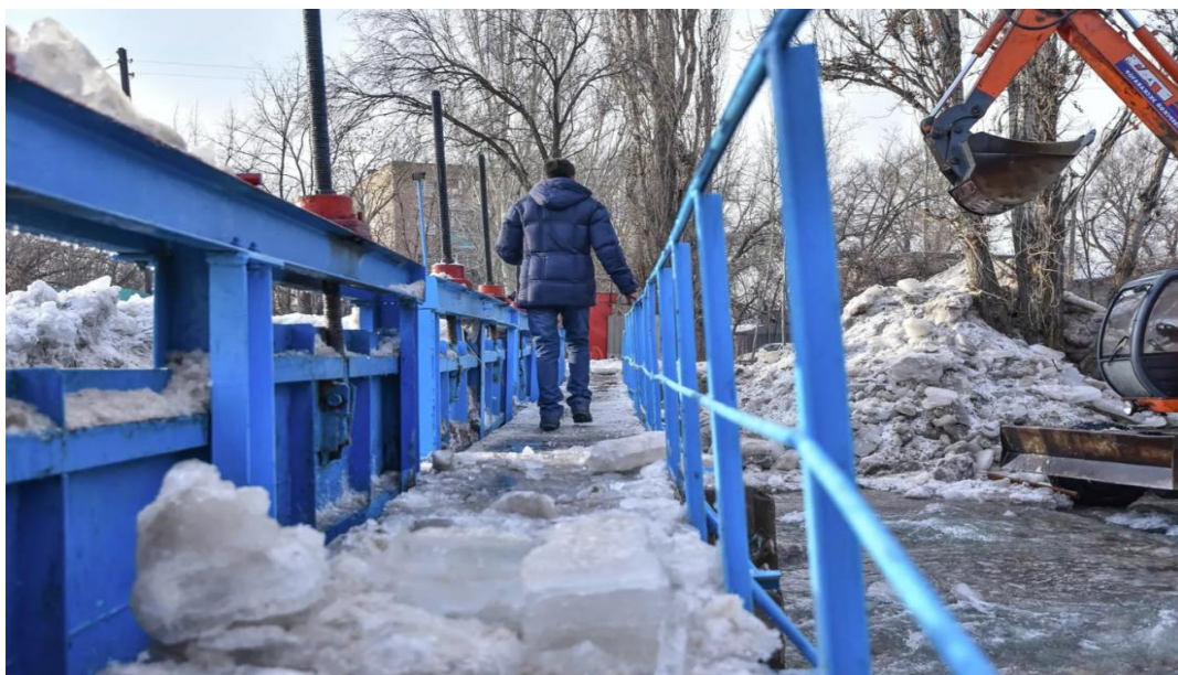
Рисунка 2.4.1 - Пешеходный мост с водораспределительным сооружением на реке Ала-Арча, на участке ул. Скрябина, после очищения от зажора ниже сооружения
