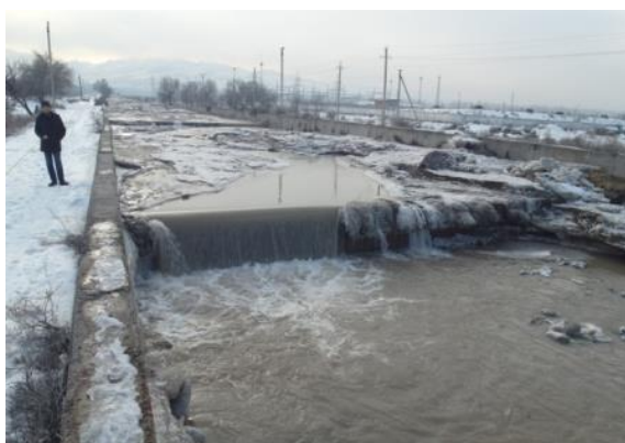
Рисунок 1.1.6 - Ступенеобразная форма русла реки Ала-Арча крайне благоприятна для «водоледяных селей» увеличения расхода
