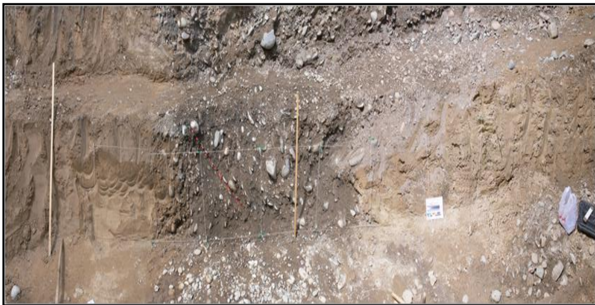
Рисунок 3.1.2.1 - Фотография западной стенки траншеи 1- траншеи западной части города Нарын (см. рис. 3.20).
