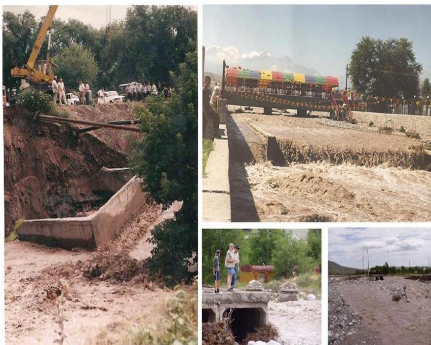
Рис. 5.5. Селевой поток ливневого типа в долине реки Ала-Арча сформировал 23 июля 2003г паводок, расход которого в пределах города Бишкек достигал 40-45 м<sup>3</sup>/с. (фото Ерохин С.А.)
