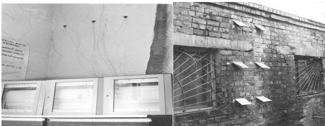
Рисунок 3.1.2 - Общий вид и местоположение измерительных приборов на внутренней и внешней поверхностях ограждений лабораторного корпуса
