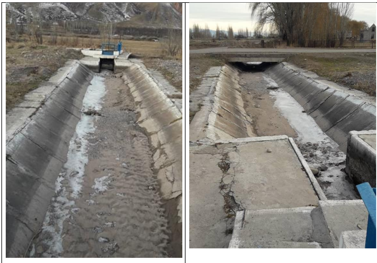
Рис.5.2 Водомерное сооружение в канале Тогузак.
