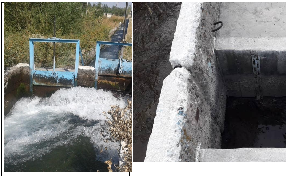
Рис.5.4 Водомерное сооружение на канале Жетиген
