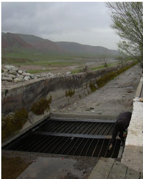
Рисунок 3.8 – Вододелитель конструкции Лаврова Н.П., Бейшекеева К.К., Аджыгуловой Г.С. и др. (ВКСТ)
