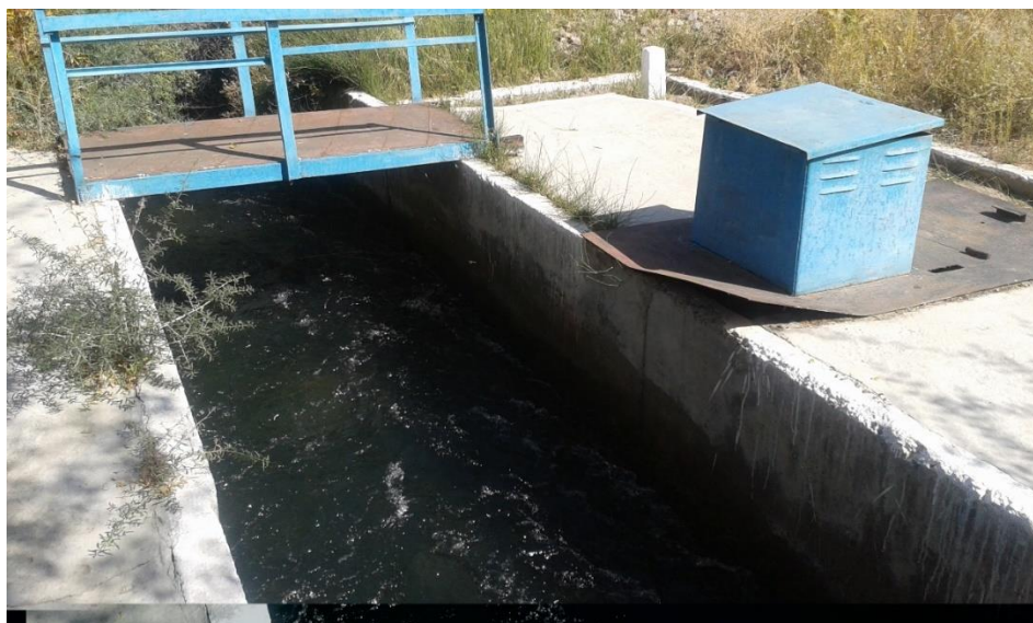
Рис.5.1. Водомерное сооружение в голове канала Жетиген (балансовый створ)
