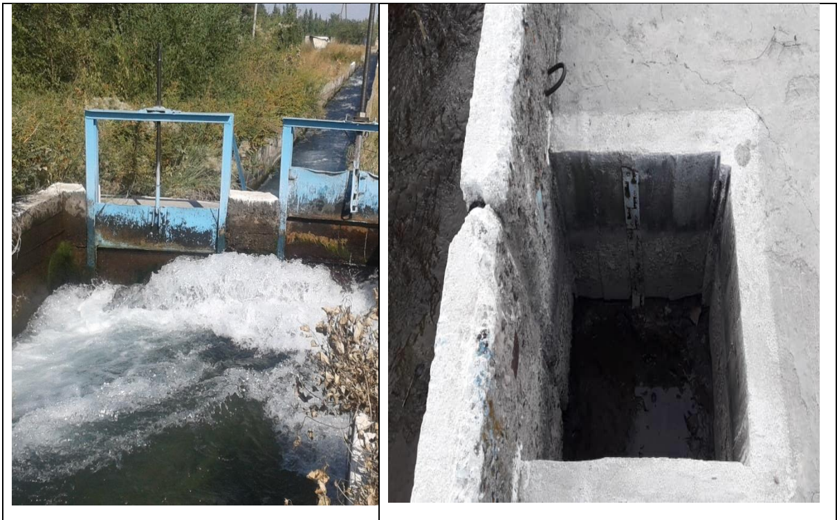
Рис.5.4 Водомерное сооружение на канале Жетиген
