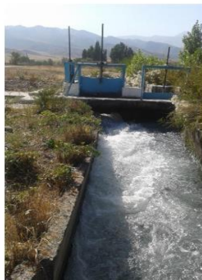
Рисунок 3.5 - Водораспределительный узел на канале Жетиген:
