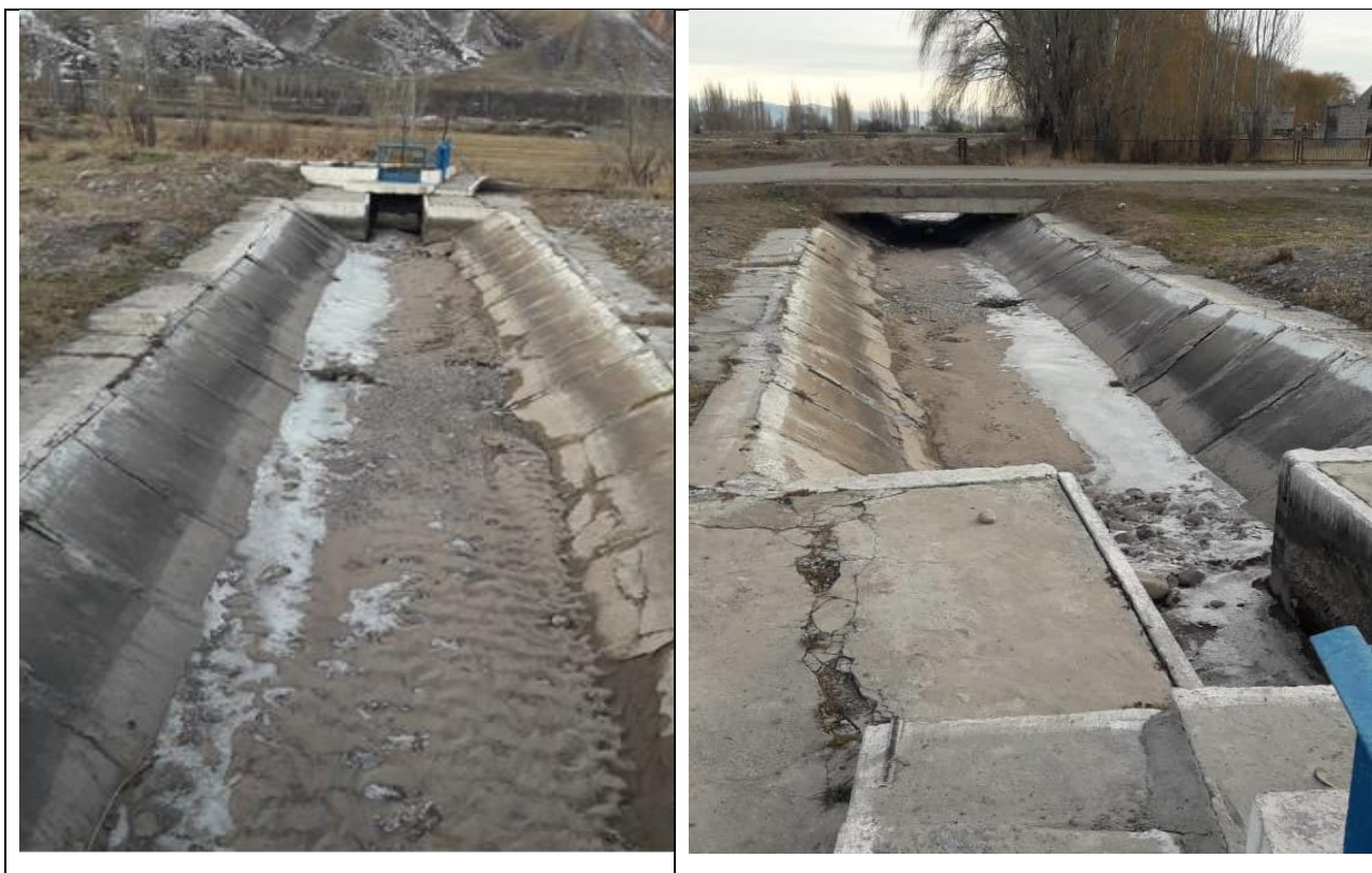
Рис.5.2 Водомерное сооружение в канале Тогузак.
