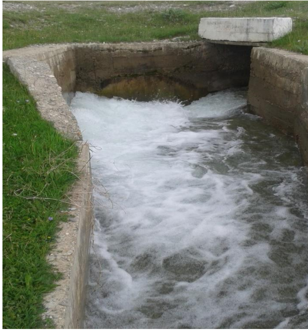
Рисунок 4.2 – Поворотный участок канала-быстротока «Ташрабат-Шырыкты»
