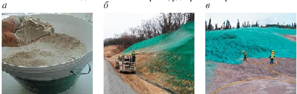
**Рис 4.5 - Метод гидромульчирования перед рекультивацией:** *а* — мульча на основе целлюлозы; *б* — гидромульчирование откосов автодорог; *в* — создание растительного слоя на поверхности породного отвала.
