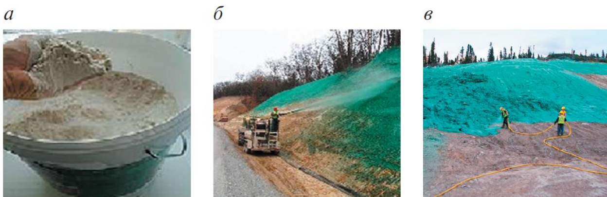
Рисунок 4.5 – Метод применения гидромульчирования перед рекультивацией поверхности земли*
