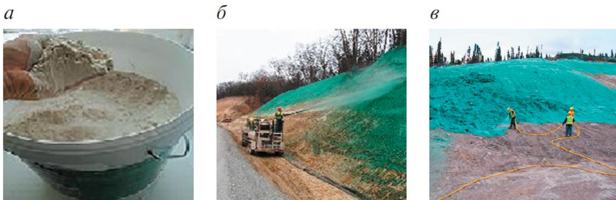
Рисунок 4.5 – Метод применения гидромульчирования перед рекультивацией поверхности земли*
