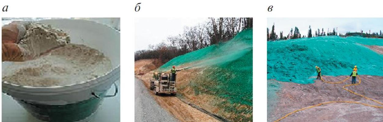
**Рис 4.5 – Метод применения гидромульчирования перед рекультивацией поверхности земли:**
