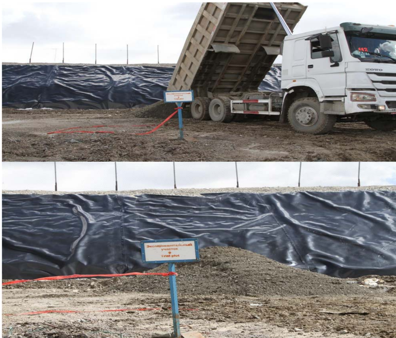
Рисунок 2.3.3 Экспериментальные работы на полигоне опасных отходов, 2019г
