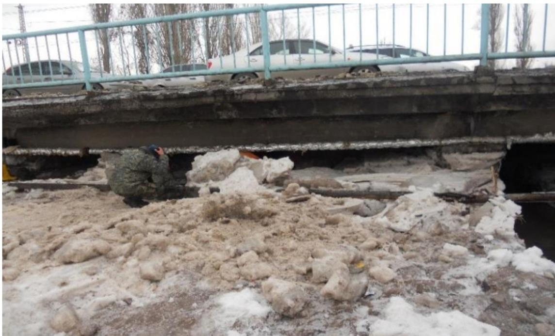
Рисунок 2.1.2 - Вид на зажор за мостом автомагистрали, на пересечении река Ала-Арча и ул. Льва Толстого, зимой после 28 января 2018 года. Снимок автора снят с северной стороны моста. Вода с крайнего правого пролета моста пробила себе туннель и затор был прекращен
