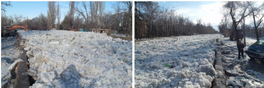
Рисунок 1.1.5 - Скопление шуги в русле р. Ала-Арча перед шлюзами водораспределителя по ул. Скрыбина и Малдыбаева
