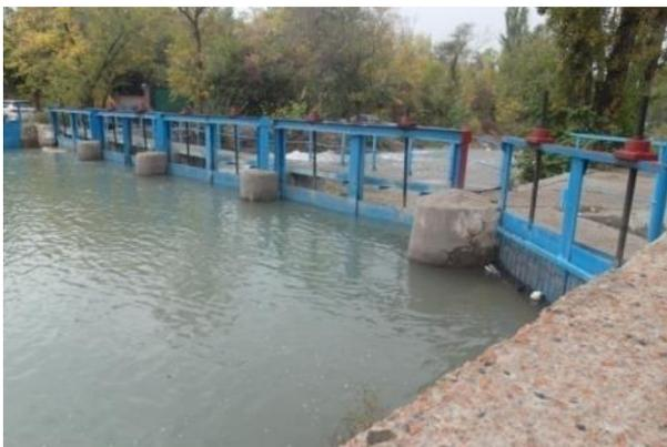
Рисунок 1.1.1. Водораспределительное сооружение на р. Ала-Арча. Подпор летом
