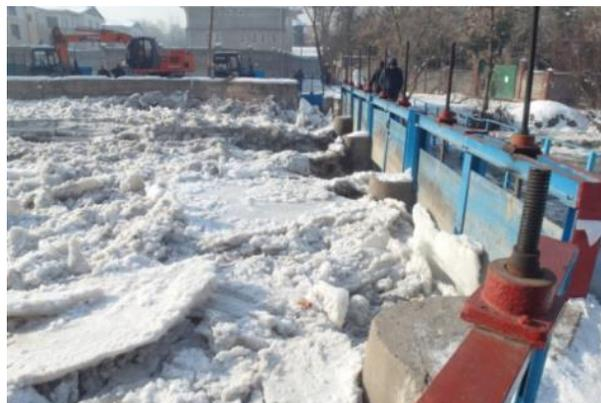
Рисунок 1.1.2. Водораспределительное сооружение на р. Ала-Арча. Затор зимой
