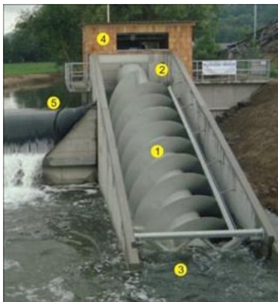
Рисунок 1.8 – МикроГЭС со шнековым механизмом
