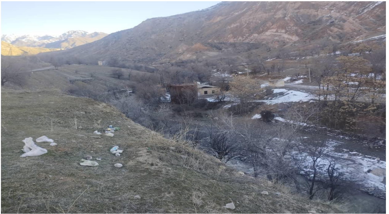
Рисунок 2.1.9 – Заброшенное здание рудно-обогачительной фабрики Майлуу-Суу и рядом расположена хвостохранилище № 8.
