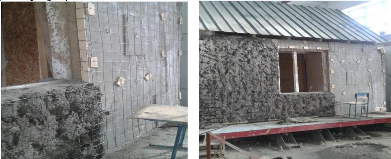
Рисунок 22 - Установка вертикальных сеток снаружи с оставлением зазора 15-20 мм и штукатурка цементно-песчаным раствором.
