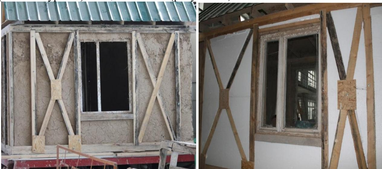
Рисунок 21 - Общий вид заполнения каркаса между стойками и раскосами с пенопластом
