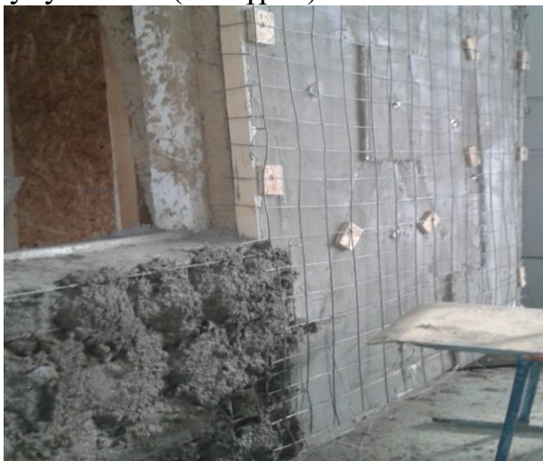
22-сүрөт. - 15-20 мм боштук калтырып сыртынан вертикалдуу торду орнотуу жана цемент-кум ылайы менен шыбап.
