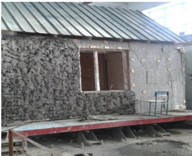
22-сүрөт. - 15-20 мм боштук калтырып сыртынан вертикалдуу торду орнотуу жана цемент-кум ылайы менен шыбап.
