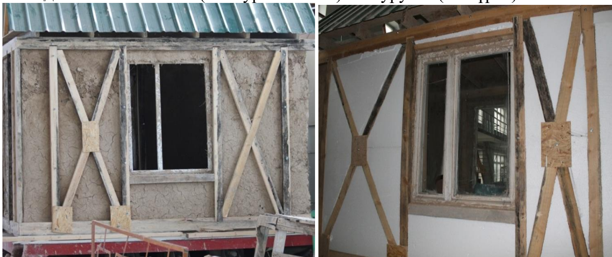
21-сүрөт. - Мамылар менен кашаанын ортосундагы каркасты пенопласт менен толтуруунун жалпы көрүнүшү.
