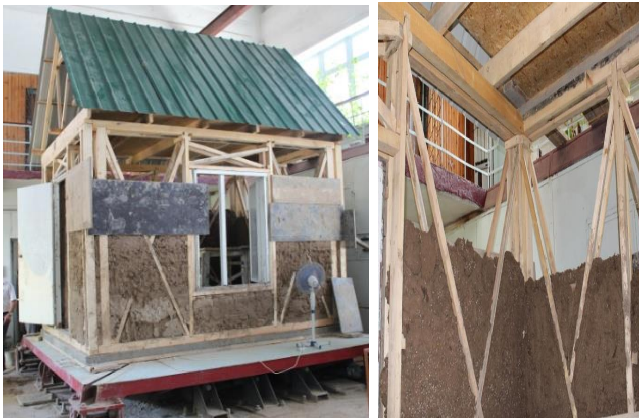
Рисунок 5.3 - Модель дома «сынч» в процессе строительства.
