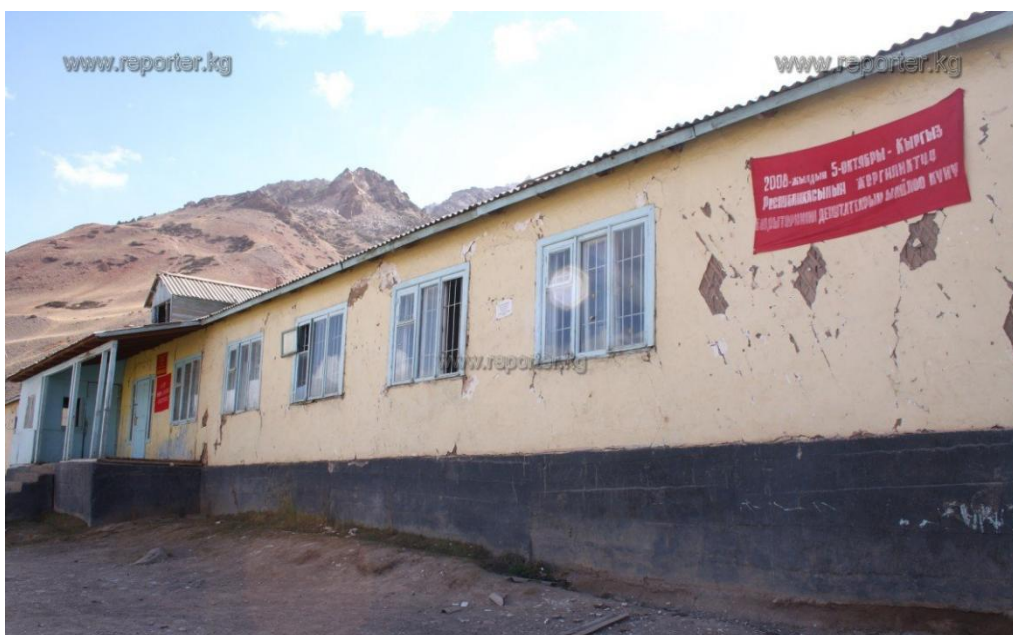
Рисунок 2.2 - Деревянные щитовые дома после землетрясения.
