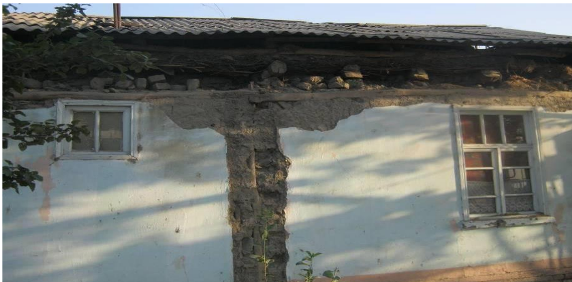
Рисунок 2.14 - Замена глино-саманных кровель на кровли из асбестоцементных волнистых листов.
