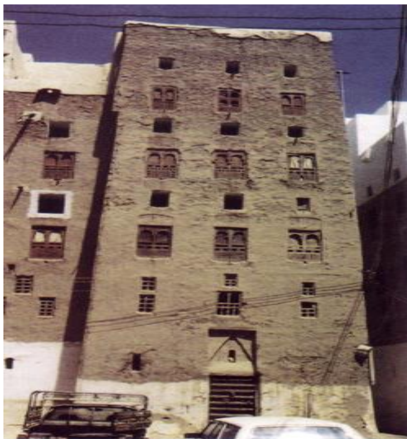
Рисунок 1.1 - Многоэтажный дом из кирпича сырца в Йемене.
