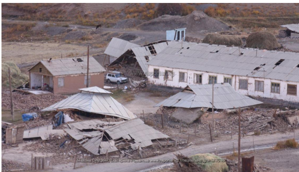
Рисунок 1.3 - Состояние домов после землетрясения в с. Нура [141].
