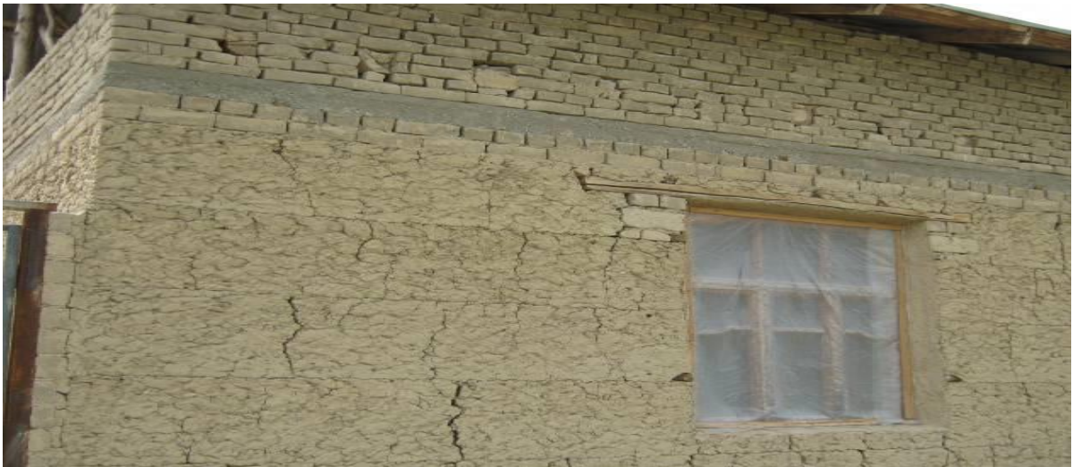
Рисунок 2.10 - Здание со стенами из пахсы современной постройки
