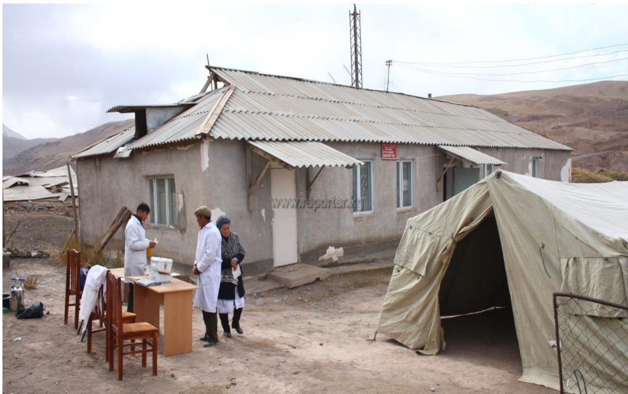
Рисунок 2.3 - Здания больницы, построенного из жженого кирпича, после землетрясения.
