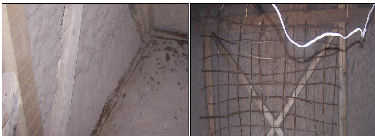
Рисунок 6.2 - Каркас и сетка из прутьев установленные в стену.
