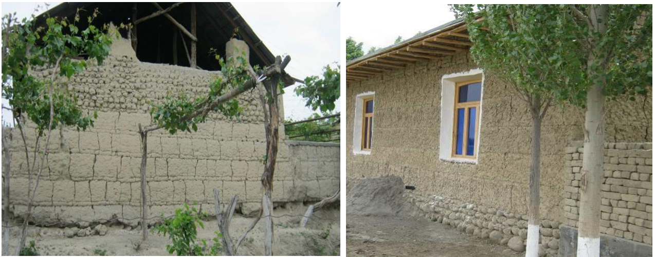
Рисунок 2.8 - Здание со стенами из пахсы.
