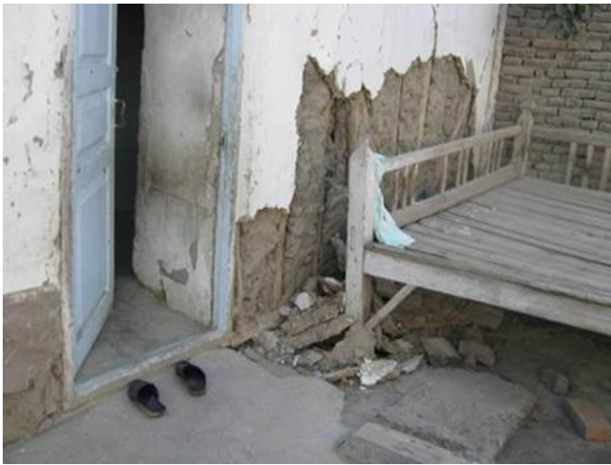
Рисунок 2.6 - Повреждения стен сынчевых домов при землетрясении 20.07.2011г.
