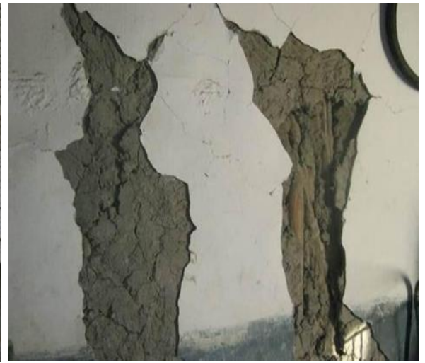
Рисунок 2.6 - Повреждения стен сынчевых домов при землетрясении 20.07.2011г.
