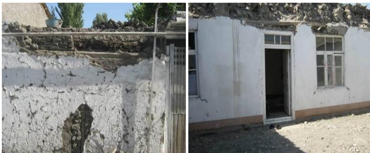
Рисунок 2.13 - Конструктивные решения покрытий зданий с глиняными кровлями.
