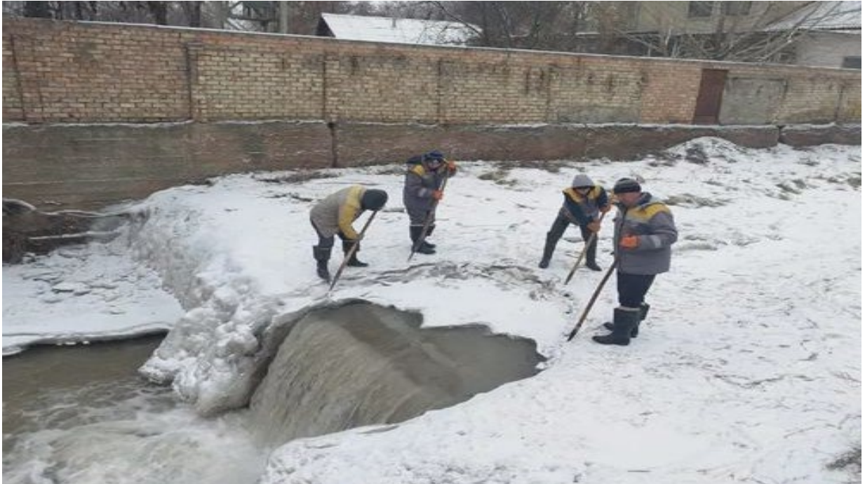
Рисунок 1.5-22 – Вид на водопад в русло реки Ала-Арча, выше моста. В 2017-2018 годы на этом участке ступенька и платина не были, был хвоста мощного зажорного затора, голова которого аж, была за мостом (см. рис. 3.1-2). На снимке, уже до 14 январь 2023 года, плотина высотой более 2,0 метр, со ступенькой, близко горизонтальной, по краям ниже борта плотины, и по середине есть водопадом, где рабочие водохозяйственной организации ведут профилактическую работы
