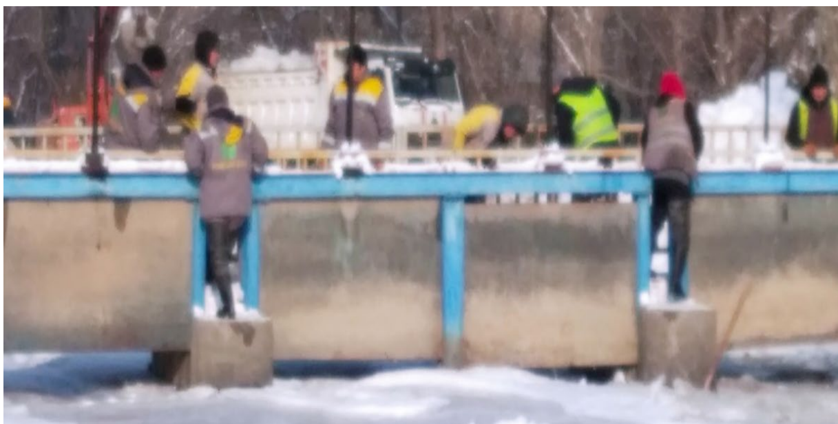
Рисунок 2.1.1 – Вид на заторы в русле реки Ала-Арча, сформированные из зазорных накоплений за сооружением, в холодный ночь в 13 январь 2023 г.
