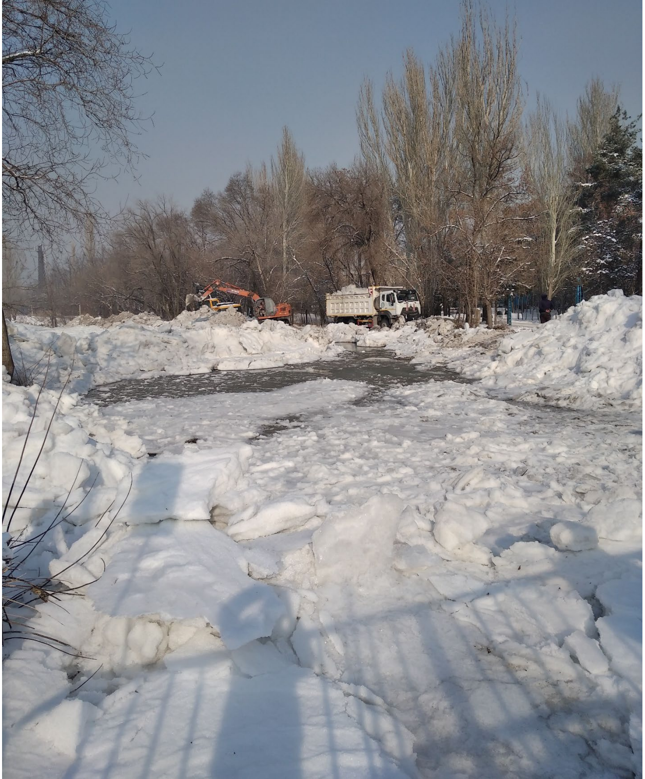
Рисунок 1.5-17 – Вид на результаты работы спецтехники, очищавшие русло реки за ВРиРГТС и продолжающие ликвидацией головы зажорного затора, сформированного на большом объеме от зажорного поступления на водопаде участке русла реки Ала-Арча, на против территории институтов от НАН КР, где там, 13 января 2023 года пешеходные тропа к ним были затоплены.
