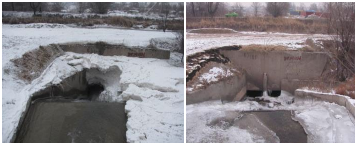
Рисунок 1.1.9 -Участок затопления выше водосброса под каналом БЧК
