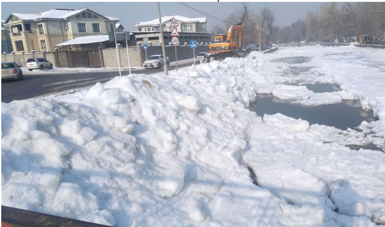
Рисунок 1.5-12 – Русло реки Ала-Арча, видом с пешеходного моста в сторону ВРиРГТС, где видны результаты работы спецтеники, где вскрыли поток воды от зажорного покрова, приближая к ГРС. На снимке от 13 январь 2023 г., где как видны силуэты людей, работающие освобождением потока воды на проход через межстойки от ВРиРГТС.
