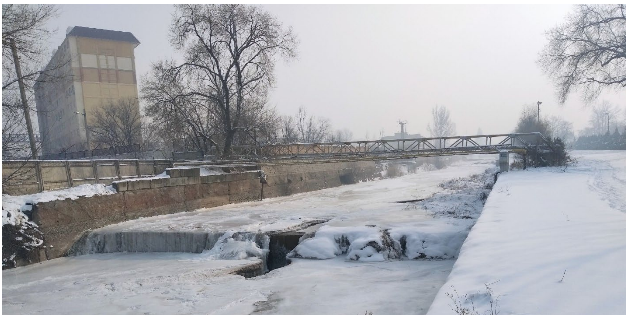
Рисунок 1.5-21. Русло реки Ала-Арча, выше моста. На снимке, от 14 января 2023 года видна плотина со ступеньками, близко горизонтальной и по середине есть водопадом, вода текут подо-льда. Были в 2017-2018 годы на этом участке (см. рис. 3.1-2) были мощный загорный затор
