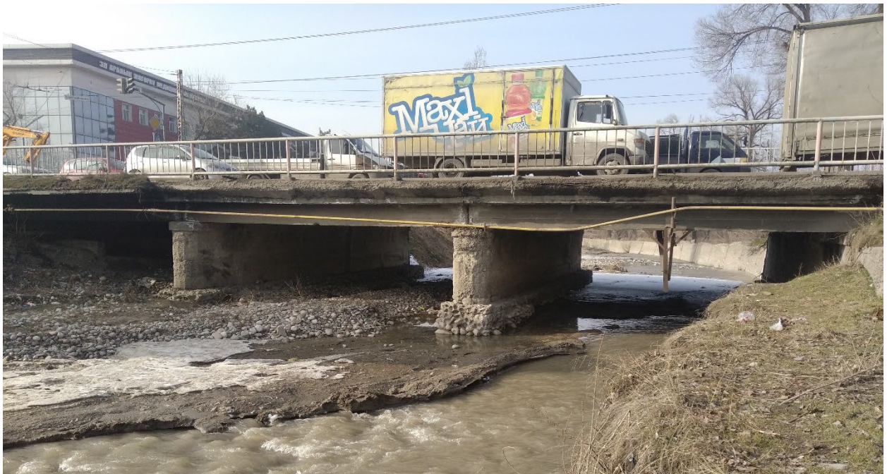
Рисунок 1.5-31 – Вид передней стороны моста, куда поступают по русле вода в под мост, как в рисунке 1.5-27. В снимке от 27 февраля 2023 года видны, что в русле реки есть останки от льда
