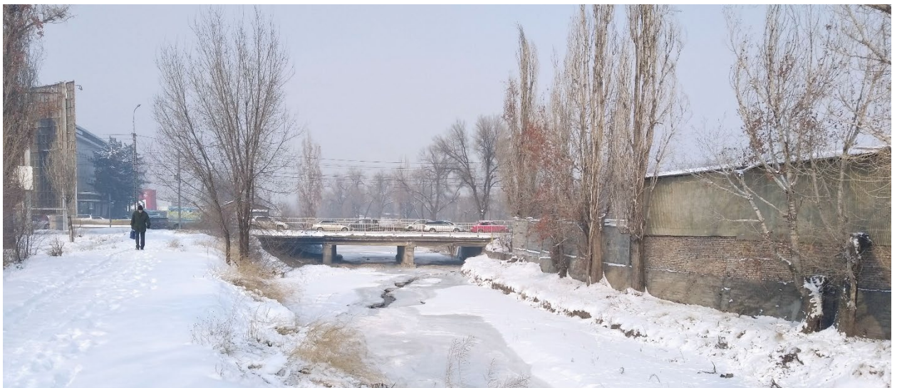
Рисунок 1.5-27 - В русло реки Ала-Арча, также без затора, видом вниз до моста по автодороги по ул. Льва Толстого. На снимке, от 14 января 2023 года видны вскрытый поток речной воды, текущие через крайний проход моста
