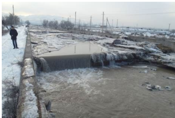
Рисунок 1.1.6 - Ступенеобразная форма русла реки Ала-Арча крайне благоприятна для «водоледяных селей» увеличения расхода
