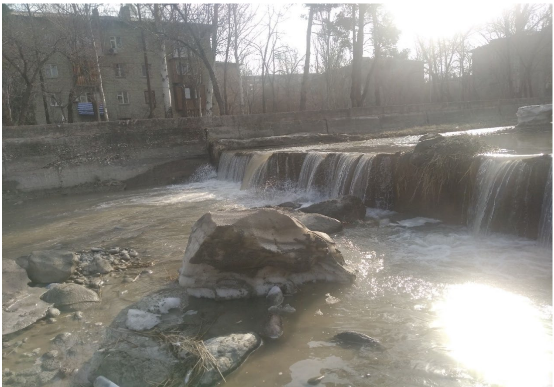
1.5 – 47- Вид на русла реки Ала-Арча, с видом на ступеньки на вес ширину русла
