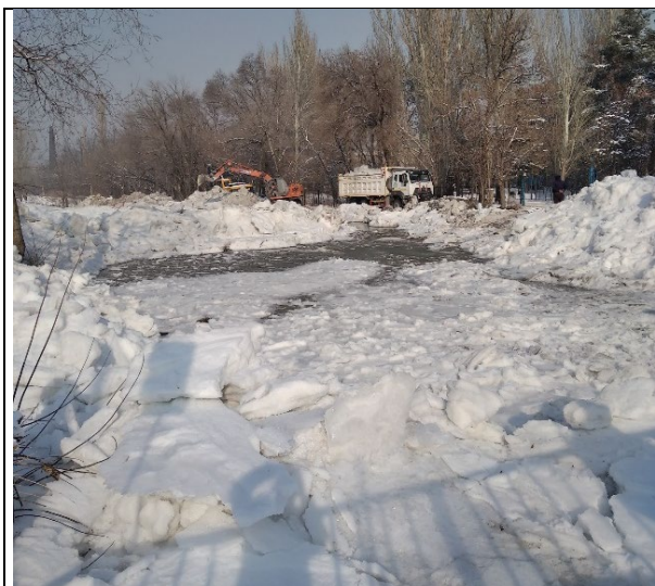
Рисунок 2.1.3 - Ликвидация «тело и головы затора» за сооружением, снимка 13 января 2023 года
