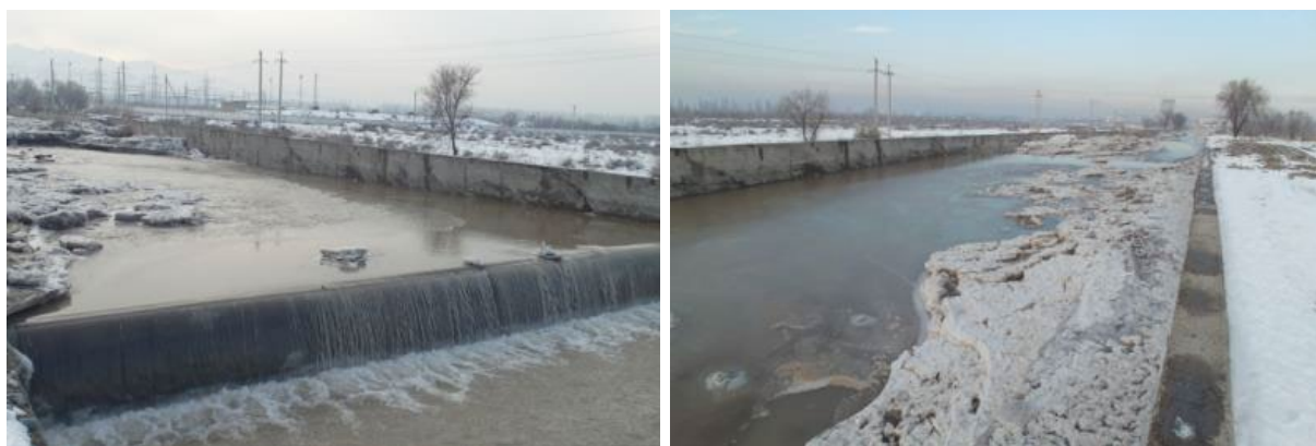
Рисунок 1.1.8 - Пороги гасят скорость потока и способствуют накоплению воды
