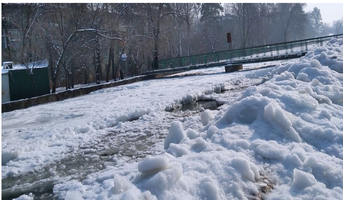
Рисунок 1.5-11 – Русло реки Ала-Арча, видом ввыше от ВРиРГТС, где видны пешеходный мост. Чтобы зажорные накопления образованные из шуги по берегам не выходили, работали спецтеники и пробивали ход потоком воды под зажором. Снимка с утра от 13 январь 2023 г. Как видны на рисунке фрагменты массовой шуги, в шарообразном виде, примерно с диаметром 4-5 мм, скопленные в кучу от низкой температуры воздуха (ниже минус 17 градус). Приближением в низ к ВРиРГТС,
