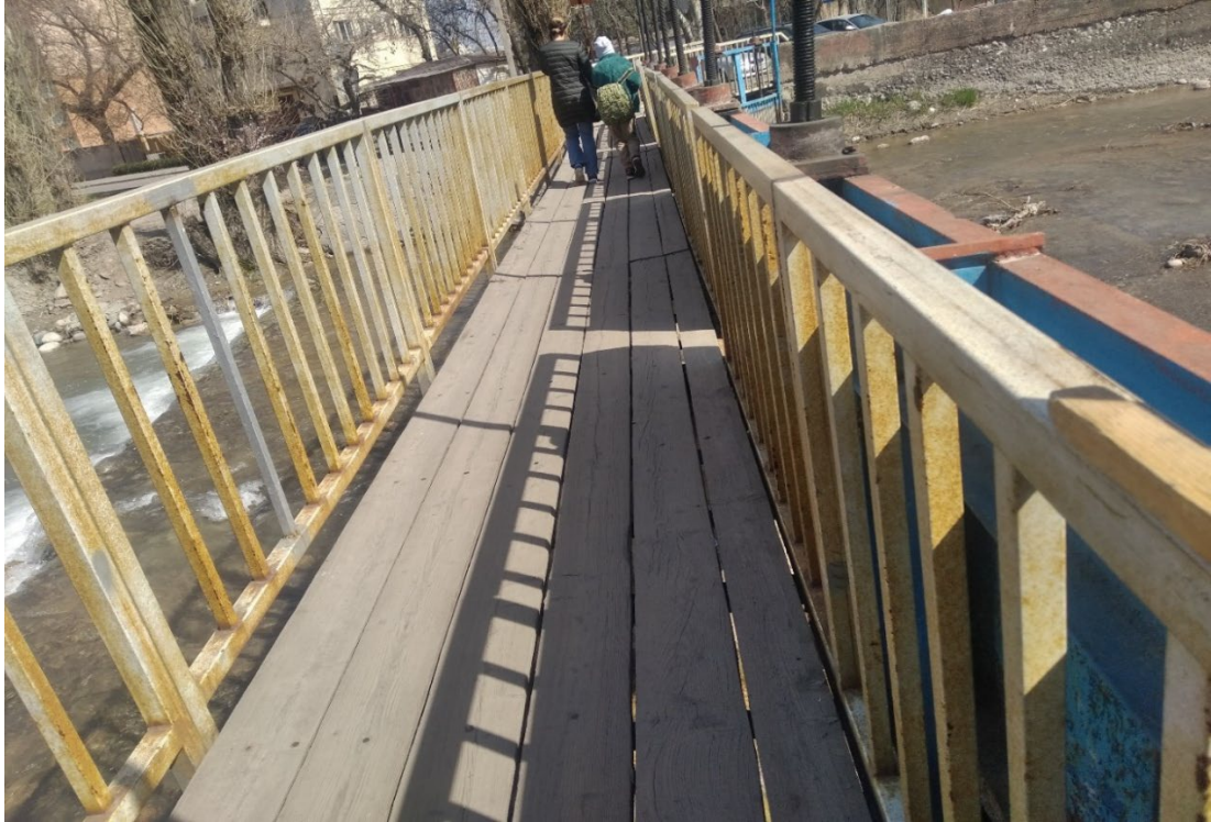
1.5 – 46- Вид на мост пешехода в составе ВРиРГТС
