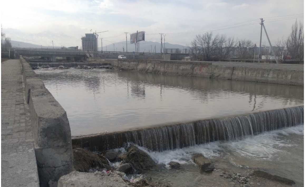
1.5 – 52- Вид на русла реки Ала-Арча, видом на ступеньки с горизонтальны дном, предназначенные снижения скорости течения паводковые воды
