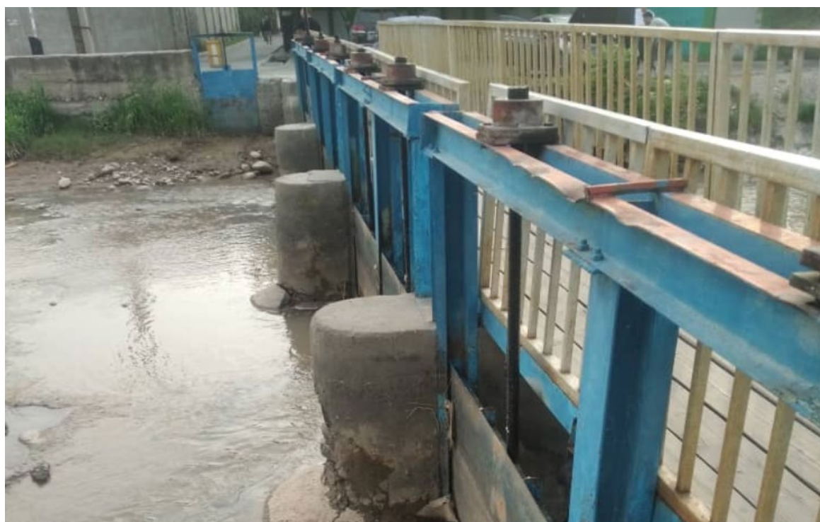
Рисунок 4.3.1 - Вид весной, по направлению съёмки, с Востока на Запада и под острым углом зрения на переднюю стенку листовых заслонок
