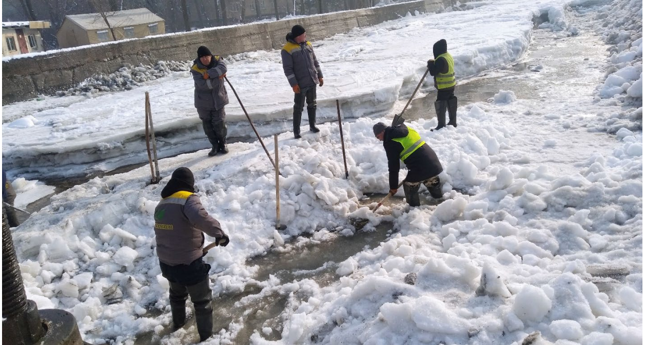
Рисунок 1.5-15 – Вид на результаты работы людей, ликвидирующие зажорные заторы у ГРС, путем освобождения ход потокам воды вскрытием зажорные покрова. Снимка 13 январь 2023 г.
