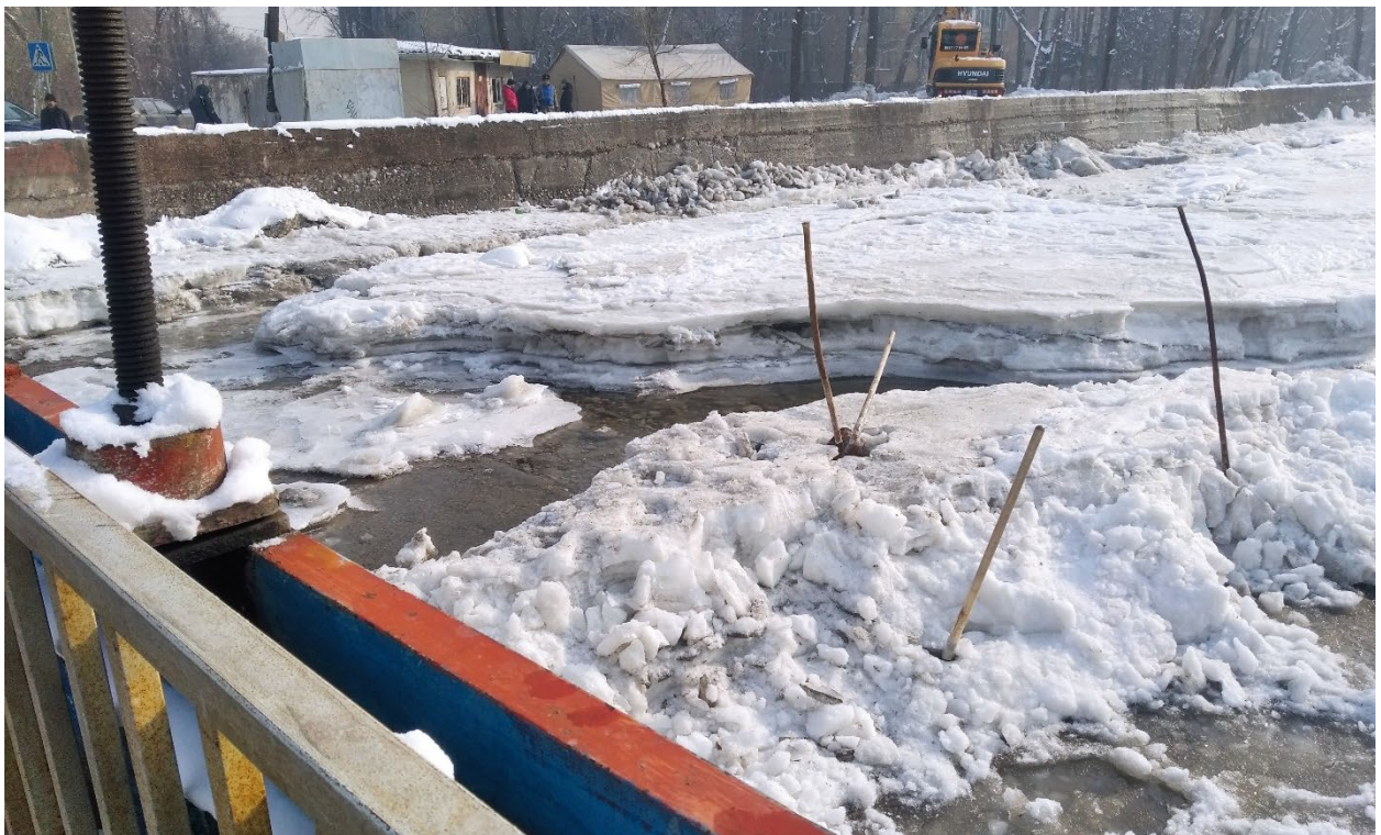
Рисунок 1.5-16 – Вид на устройства ГРС, где красная полоса – часть рамки задвижки с винтовым приводом от подвижной гайки
