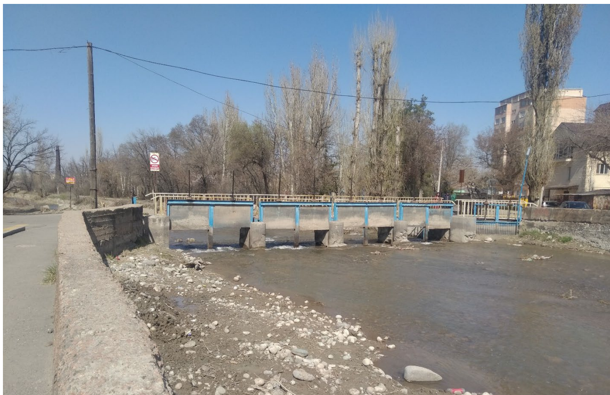
1.5-41 – Вид на ВРиРГТС на речке Ала-Арча, видом на сооружению
