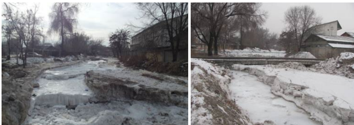
Рисунок 1.1.12 - Участок затопления в 0.1 км выше пересечения с улицей Жибек-Жолу
