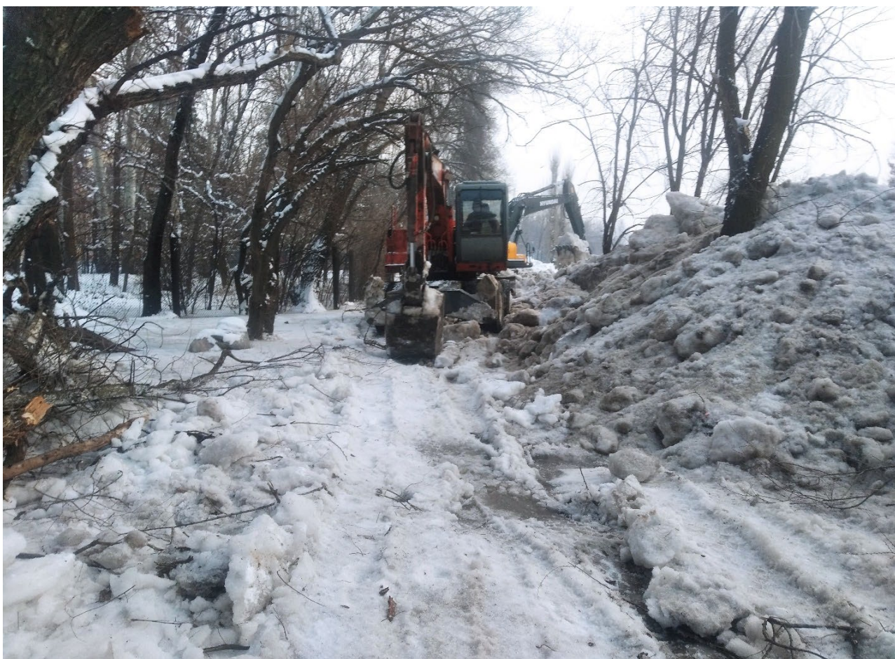
Рисунок 1.5-18 – Вид на результаты работы спецтехники, очищавшие берега русла реки за ГРС, пешеходные тропы к со стороны территории институтов от НАН КР, на 13 января 2023 года были затоплены
