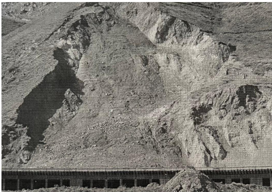
Рисунок 1.8 – Оползень над железнодорожной галереей по маршруту Бишкек-Балыкчи в Боомском ущелье в районе 115-го километра автомобильной дороги (фото С.А. Ерохина). Это активный оползень, угрожающий железной дороге разрушением галереи. Проводится регулярная расчистка оползневого завала, надвигающегося на галерею.
