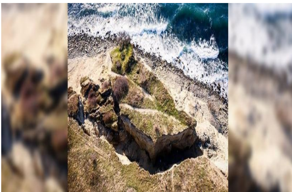
Рис. 1.14 Оползень на склоне горы Колдун (Новороссийск, 2019)
