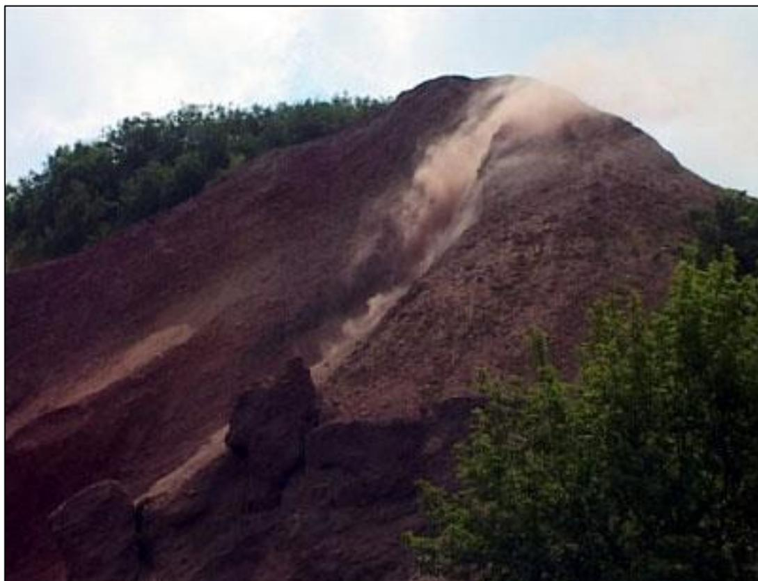
Рис. 1.12. Террикон шахты 41 – бис и обрушение террикона шахты “Центральная” (ДНР, 2011)
