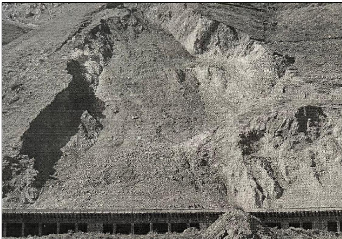
Рис. 1.8. Оползень над железнодорожной галереей по маршруту Бишкек-Балыкчи в Боомском ущелье в районе 115-го километра автомобильной дороги (фото С.А. Ерохина). Это активный оползень, угрожающий железной дороге разрушением галереи. Проводится регулярная расчистка оползневого завала, надвигающегося на галерею.
